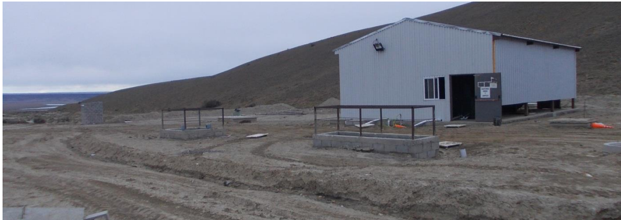
Figura 32. Planta de tratamiento de efluentes cloacales, en galpón ventilado.
