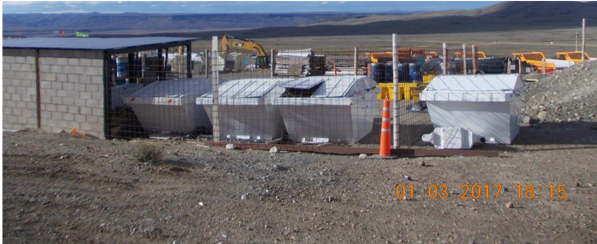
Figura 2. Vista posterior del patio de acopio de residuos peligrosos. Detalle de volquetes de acopio de suelos contaminados y residuos peligrosos.
