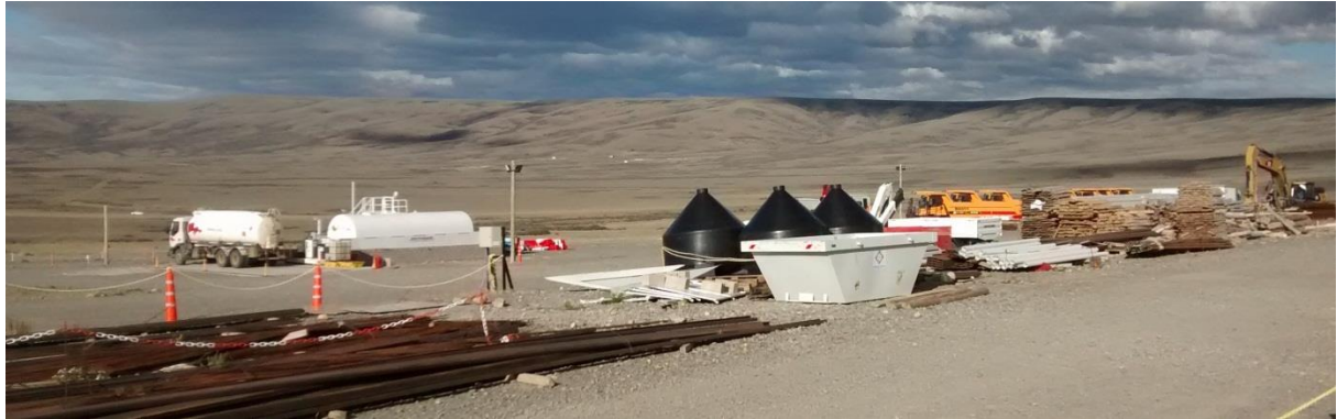
Figura 6. Sector de acopio de materiales. Al fondo, instalación habilitada de expendio de combustible, con tanque de gasoil aéreo. Se observa un camión maniobrando sobre plataforma de expendio.
