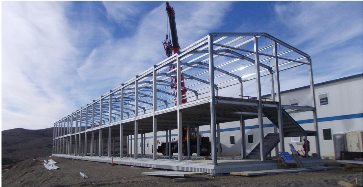
Figura 21. Vista general de montaje de estructura de módulo habitacional.
