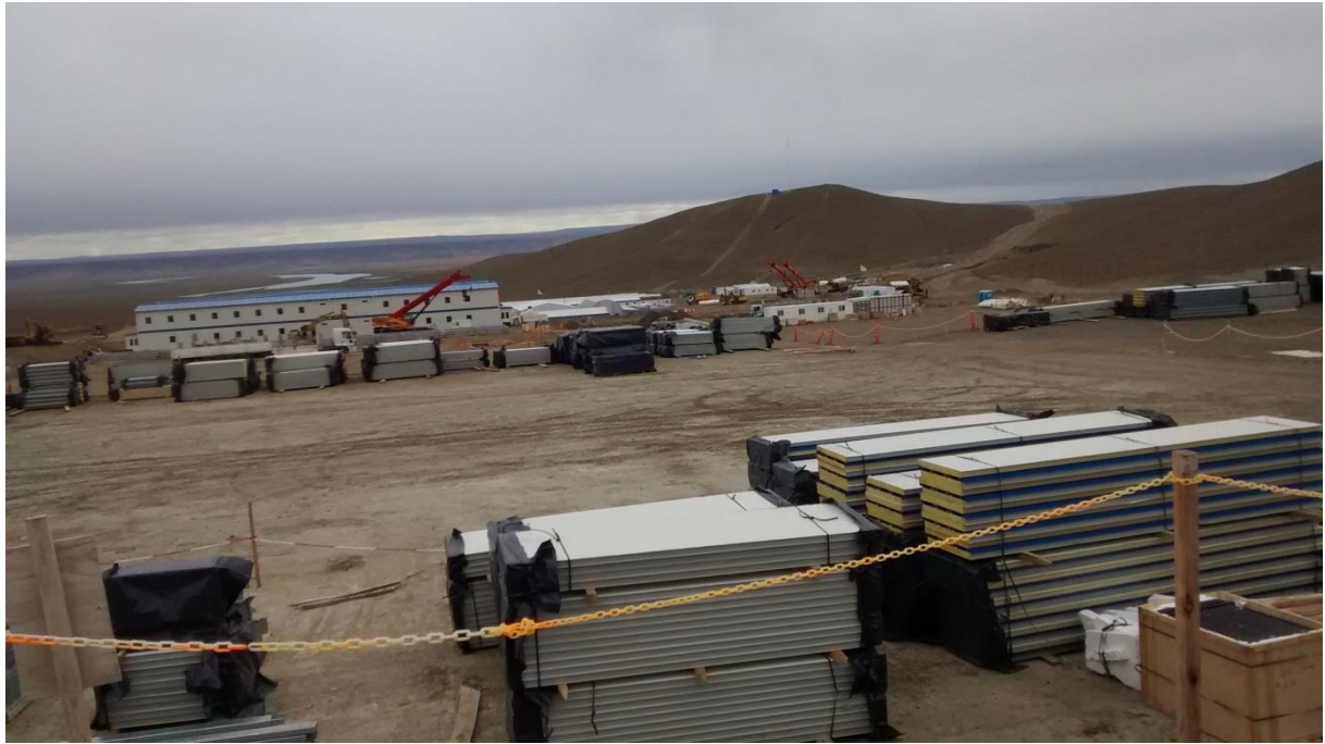
Figura 49. Vista general de la zona de trabajos.
