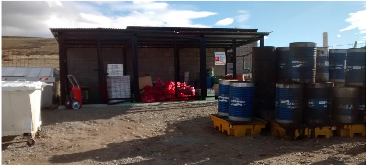
Figura 4. Recinto de acopio de residuos peligrosos (nótese el uso de bolsas rojas -típicamente utilizadas para residuos biopatógenos- para el acopio transitorio de materiales impregnados con hidrocarburos). El tinglado es insuficiente, no cuenta con sistema de prevención de derrames / contención perimetral. Se observan tambores mencionados en foto anterior, y a la izquierda contenedores / volquetes cerrados, con tapa, para acopio de suelos contaminados y otros RR.PP.
