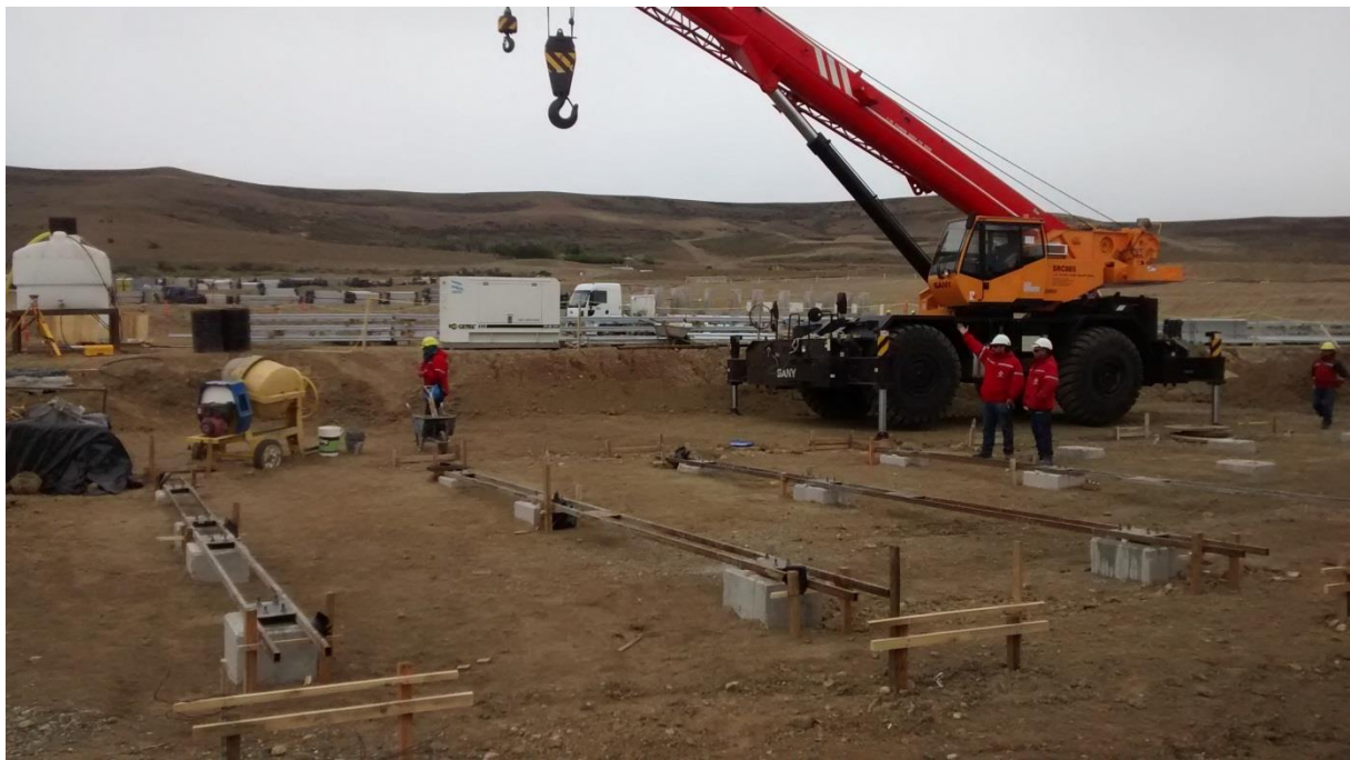
Figura 48. Frente de trabajo en montaje de unidades habitacionales.
