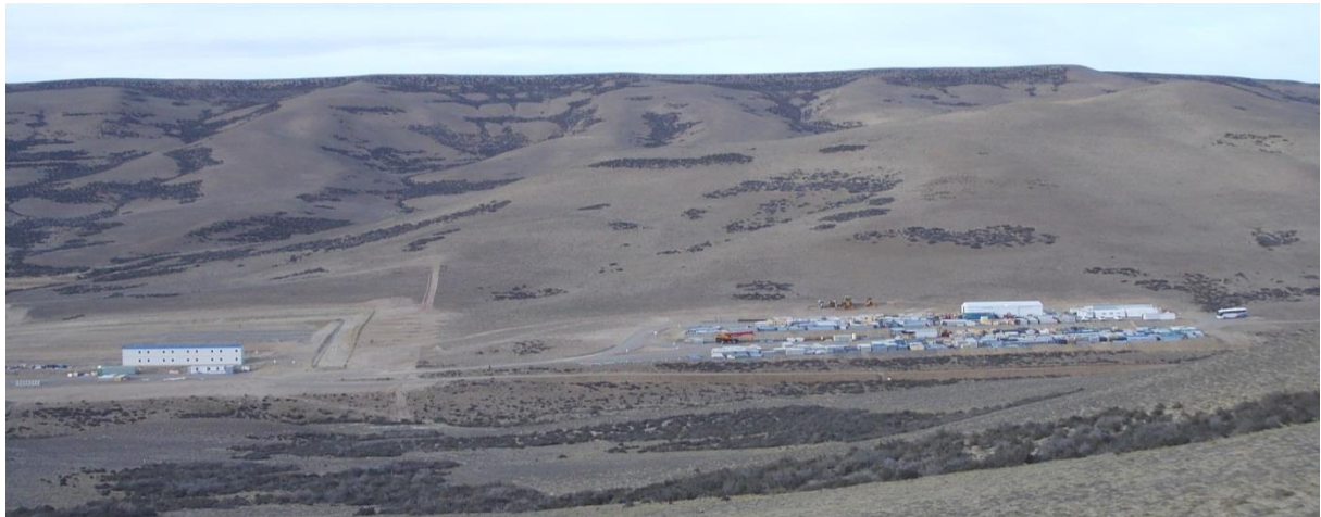
Figura 13. Vista panorámica de obrador provisorio y villa temporaria NK, desde camino de acceso.
