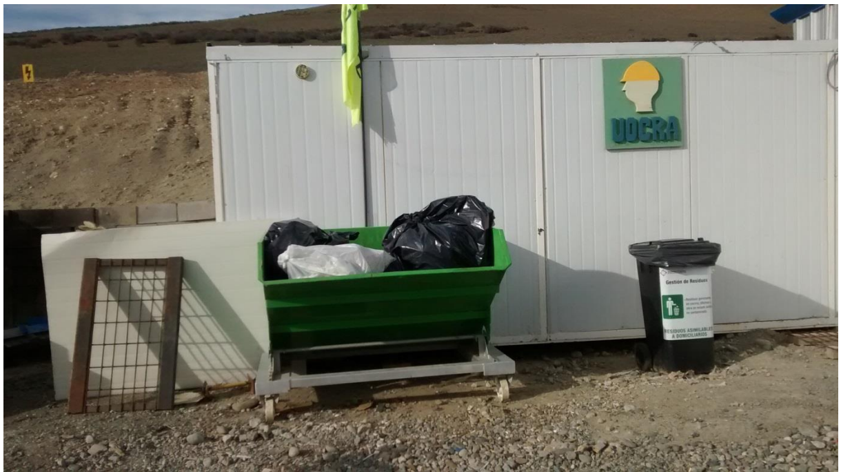
Figura 16. Contenedores para acopio transitorio de residuos sólidos en sectores del campamento y obrador.
