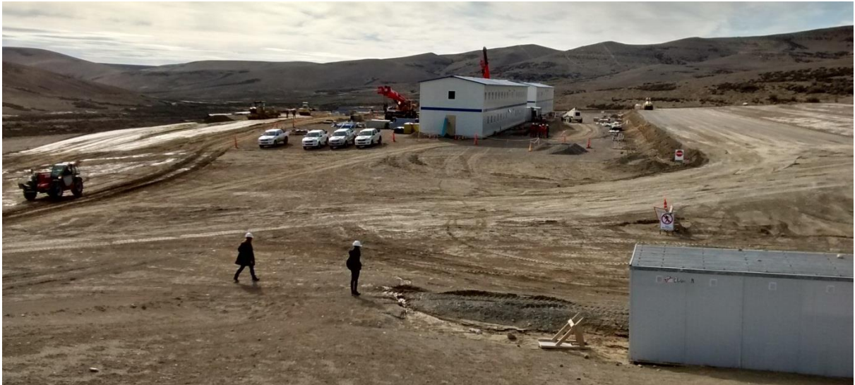
Figura 23. Vista general de obras durante el montaje de una unidad habitacional. Estacionamiento y caminos vehiculares.
