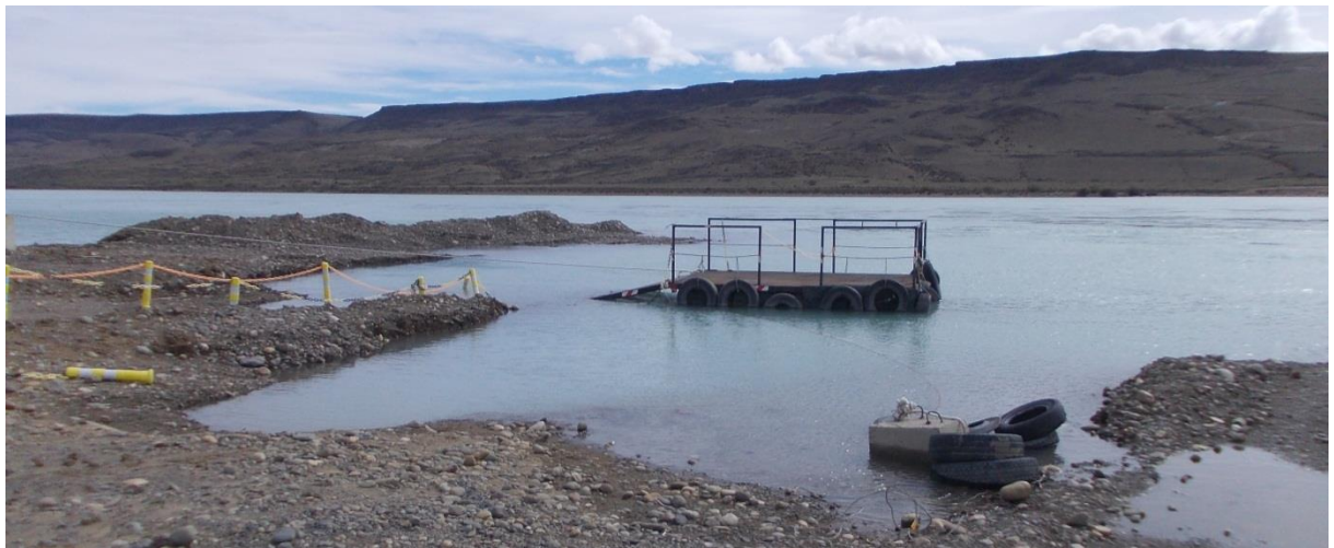
Figura 30. Zona del embarcadero (no operativo) oportunamente utilizado para cruce de personal.
