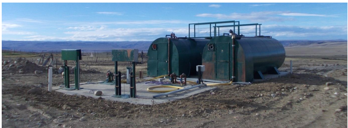
Figura 8. Planta de tratamiento de efluentes cloacales, con 2 tanques biorreactores de tratamiento por lodos activados.
