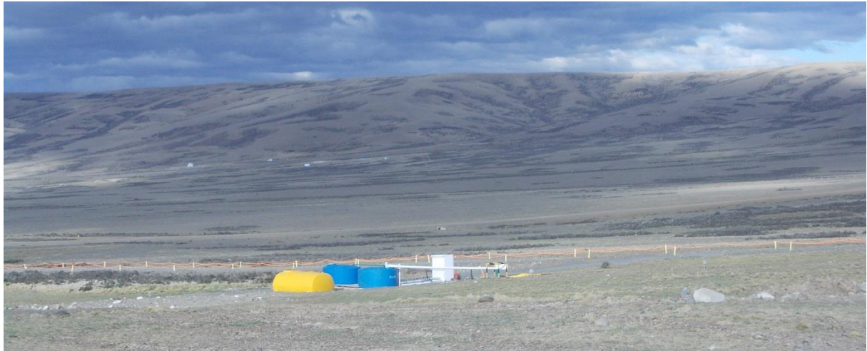
Figura 11. Instalación en pozo de bombeo de agua, para carga de camiones y transporte del agua hasta los tanques.
