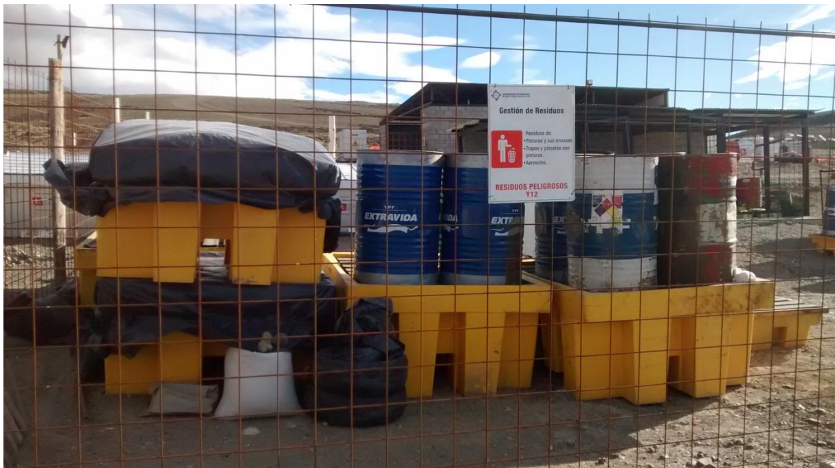
Figura 3. Recinto de acopio de residuos peligrosos. Comprende un sector cercado y de acceso limitado con candado. Cuenta con un sector tinglado (al fondo en la foto) y un sector a cielo abierto donde se observó acopio de tambores conteniendo aceites usados y/u otros residuos peligrosos generados durante los trabajos, sobre contenciones secundarias de capacidad de contención insuficiente.
