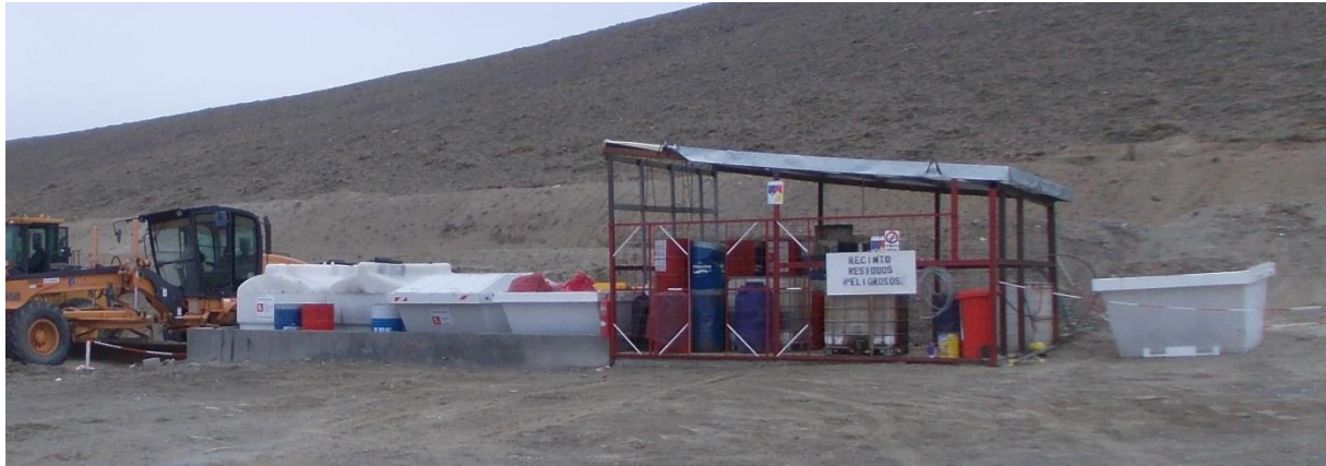
Figura 43. Recinto de residuos peligrosos. Acceso no restringido. A la izq., sector no techado con contención secundaria de hormigón, conteniendo tanques de aceite usado y volquetes de RRPP. Al centro-der, sector techado sin contención secundaria y alero insuficiente. Volquete a la derecha conteniendo suelos contaminados removidos en respuesta a un incidente ambiental.
