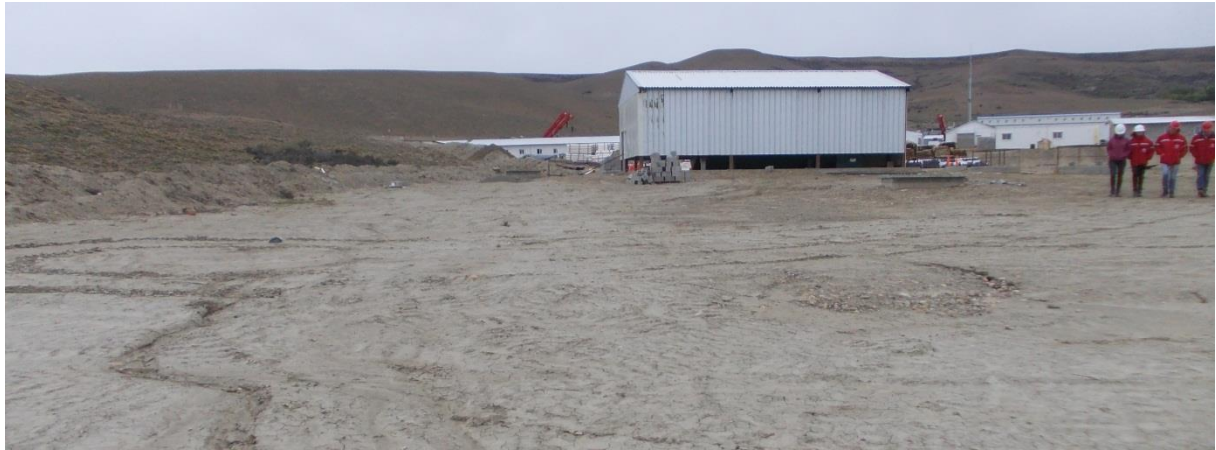
Figura 35. Área de lechos nitrificantes, en suelos arcillosos, desde donde el efluente aflora en cañadón aguas abajo.
