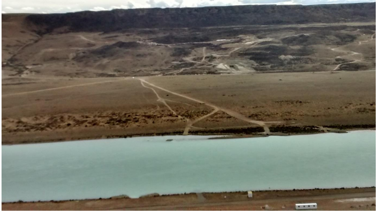
Figura 29. Vista de área del eje de la represa NK. Al fondo, se evidencian intervenciones asociadas a trabajos exploratorios de prospección geológica, incluyendo perforaciones.
